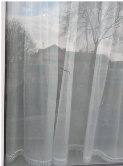
Rysunek 7 Pęknięta szyba okienna
